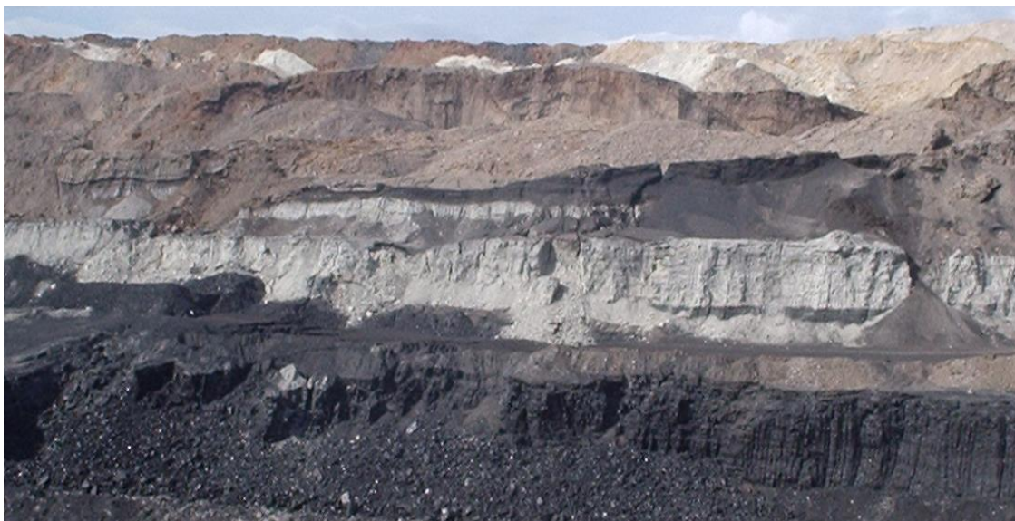
Рис. 2. Оползень прибортового массива в районе р.л. A^1 и р.л. A^3
