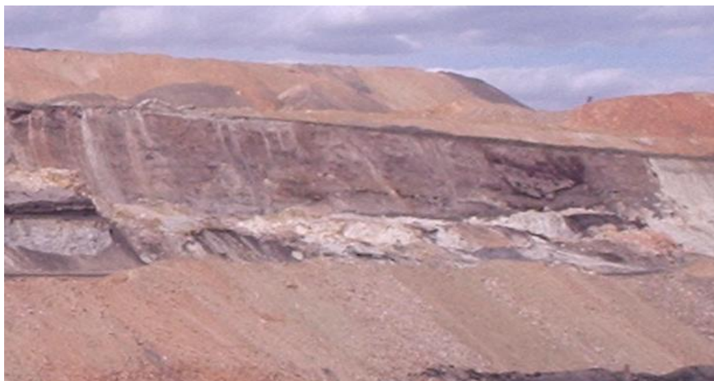
Рис. 1. Оползень борта разреза в районе р.л. A^4 и р.л. A^5
