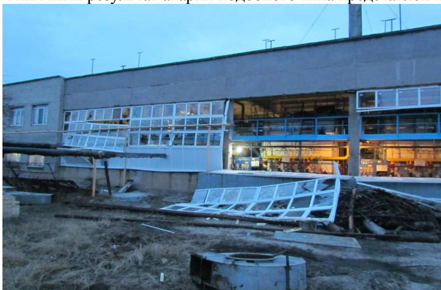
Рис.1 Результат взрыва газо-воздушной смеси в котельной
