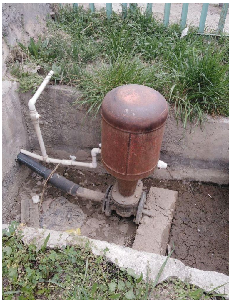
Рис. 1. Гидроударный насос.
