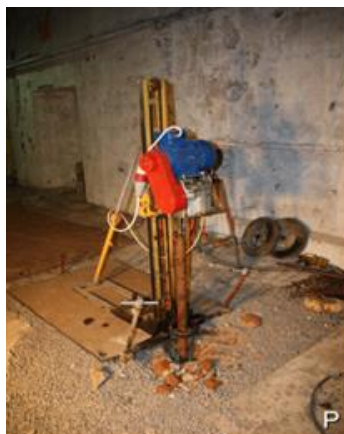
Рис. 2. Установка для бурения скважин.
