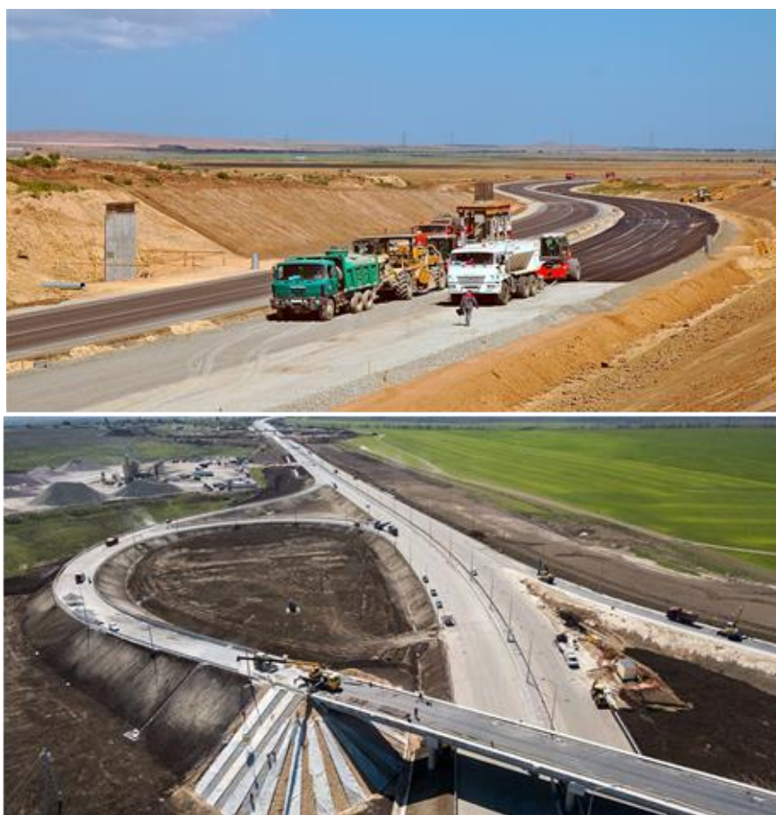
Рис. 2. Фрагменты строительных работ трассы Таврида
