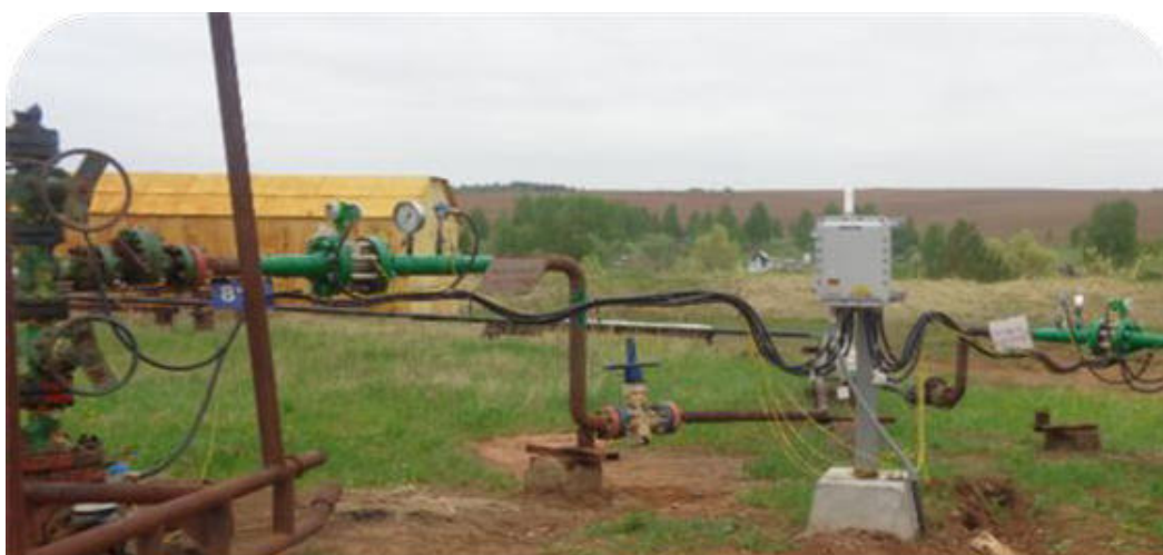
Рис.3. Узел беспроводной связи (технология WiFi) на Гремихинском нефтяном месторождении ПАО «Удмуртнефть» им. В.И.Кудинова
