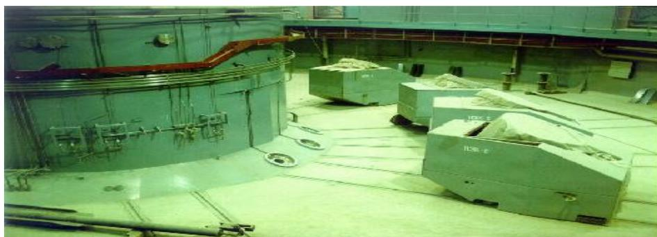
Рис. 1. Зал наклонных каналов реактора ПИК, показаны шиберы в откатной защите на выходе каналов для размещения ядерно-физических установок
