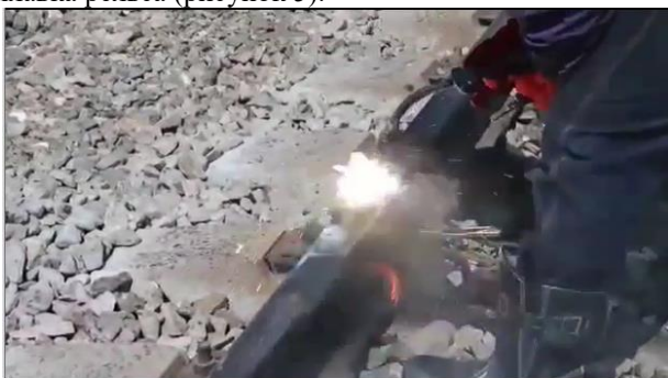
Рисунок 5 – Наплавка рельса
