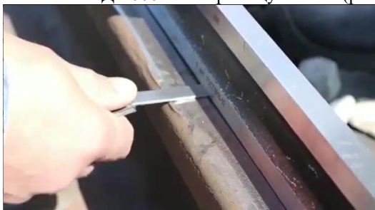
Рисунок 3 – Обмер дефектного места
