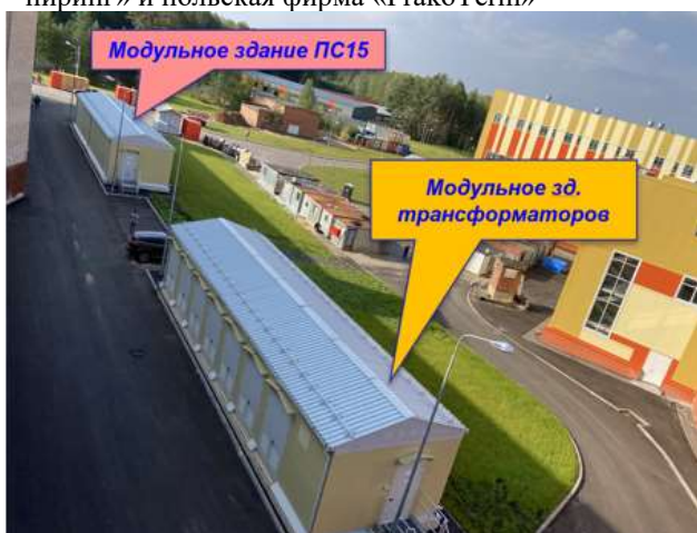
Рис 10: Построенные модульные здания трансформаторов и ПС 15 для систем питания транспортировки пучков в к.205.
