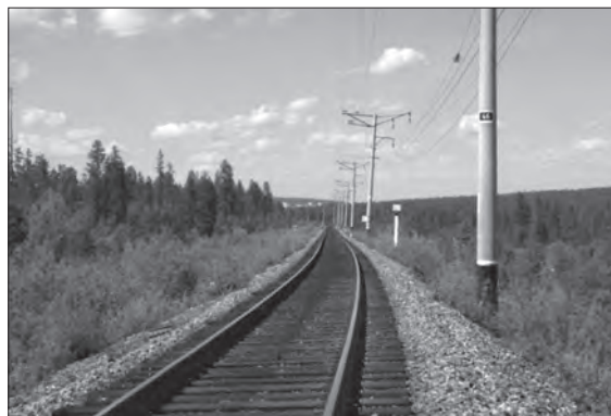
Рис. 7. Крен опор ЛЭП.
