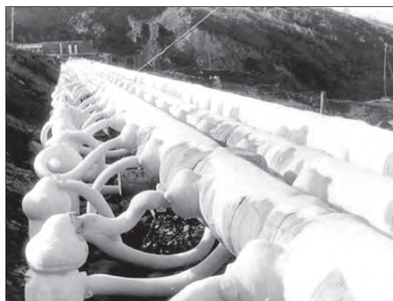
Рис. 2. Первая очередь рассолопроводов и морозильных колонок, действовавших на плотине.
