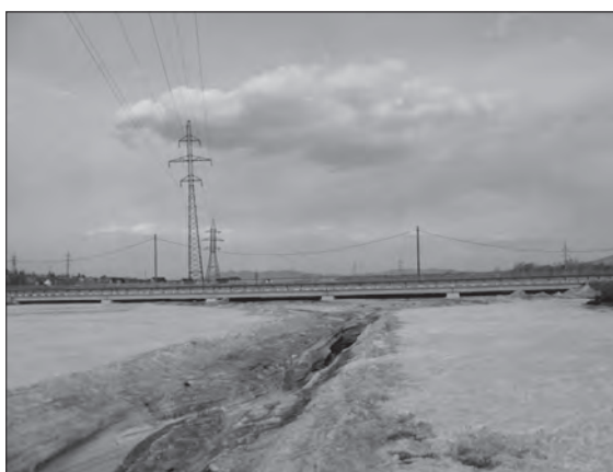
Рис. 4. Наледь на участке нового моста через р. Смоленка (апрель 2010 г.).
