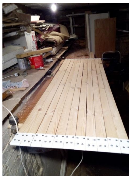
Рис. 7. Укладка ППП на горизонтальную поверхность
