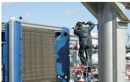
Рис. 1. Очистка наружной поверхности АВО
