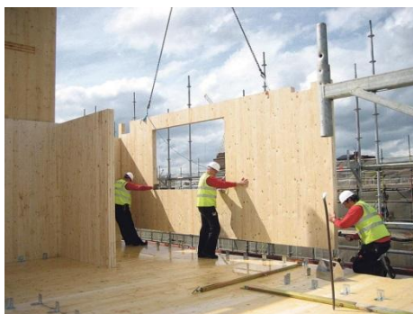
Рис. 2. Монтаж здания из CLT-плит
