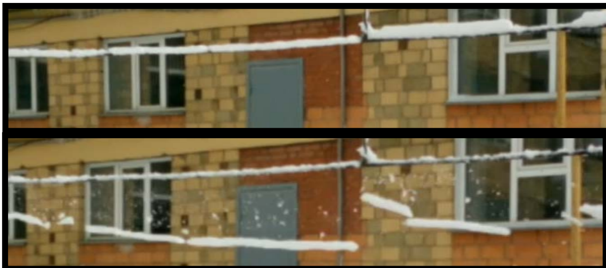
Рис. 6. Удаление снега электромеханическим способом
