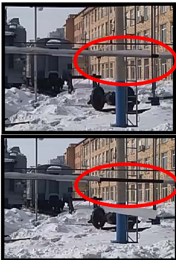
Рис. 5. Удаление льда электромеханическим способом
