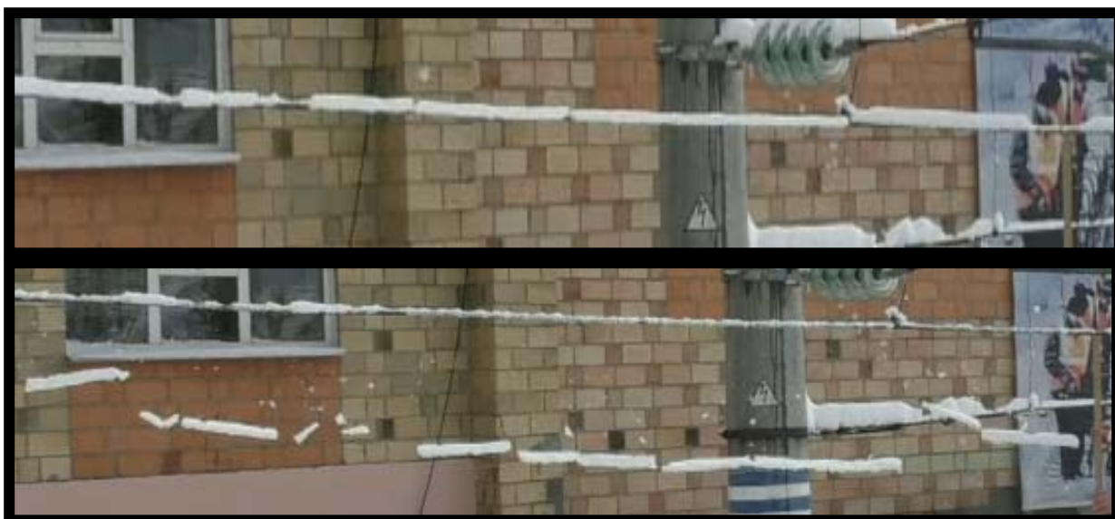
Рис. 7. Удаление снега электромеханическим способом
