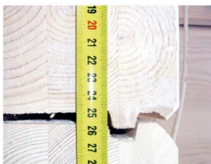
Рис. 2. Зазоры в соединении бруса
