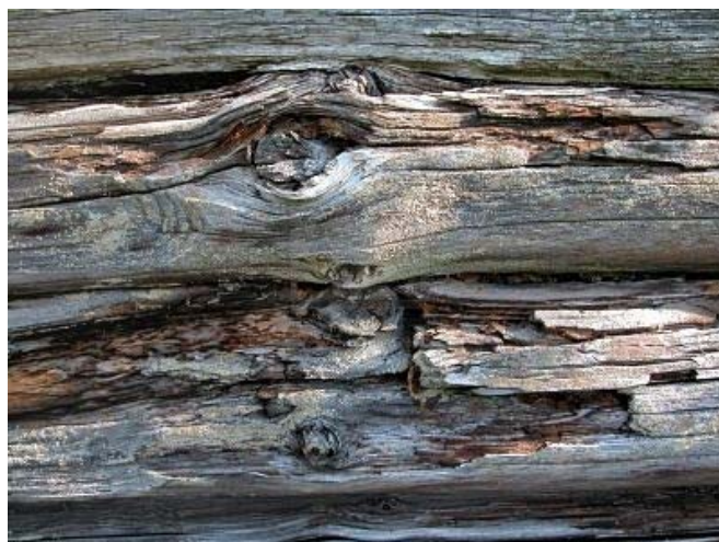
Рис. 3. Загнивание древесины
