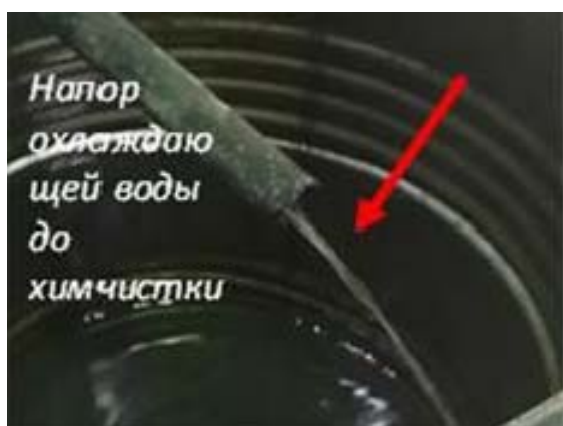
Рис. 2. Слив охлаждающей жидкости с маслоохладителя до химической очистки
