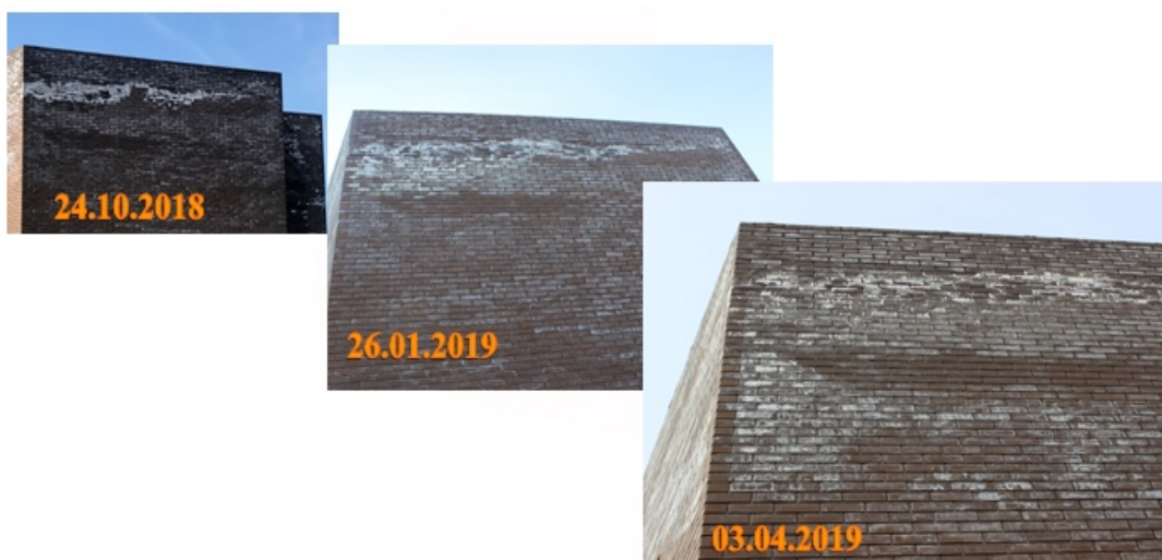
Рис. 3. Мониторинг за высоломи на поверхности облицовочного кирпича здания лаборатории
