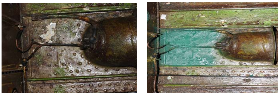
Рис. 2. Очаги коррозии глубиной 0,15 мм обшивки фюзеляжа изнутри подпольного пространства между шпангоутами № 22-23, площадью 75×50 мм
