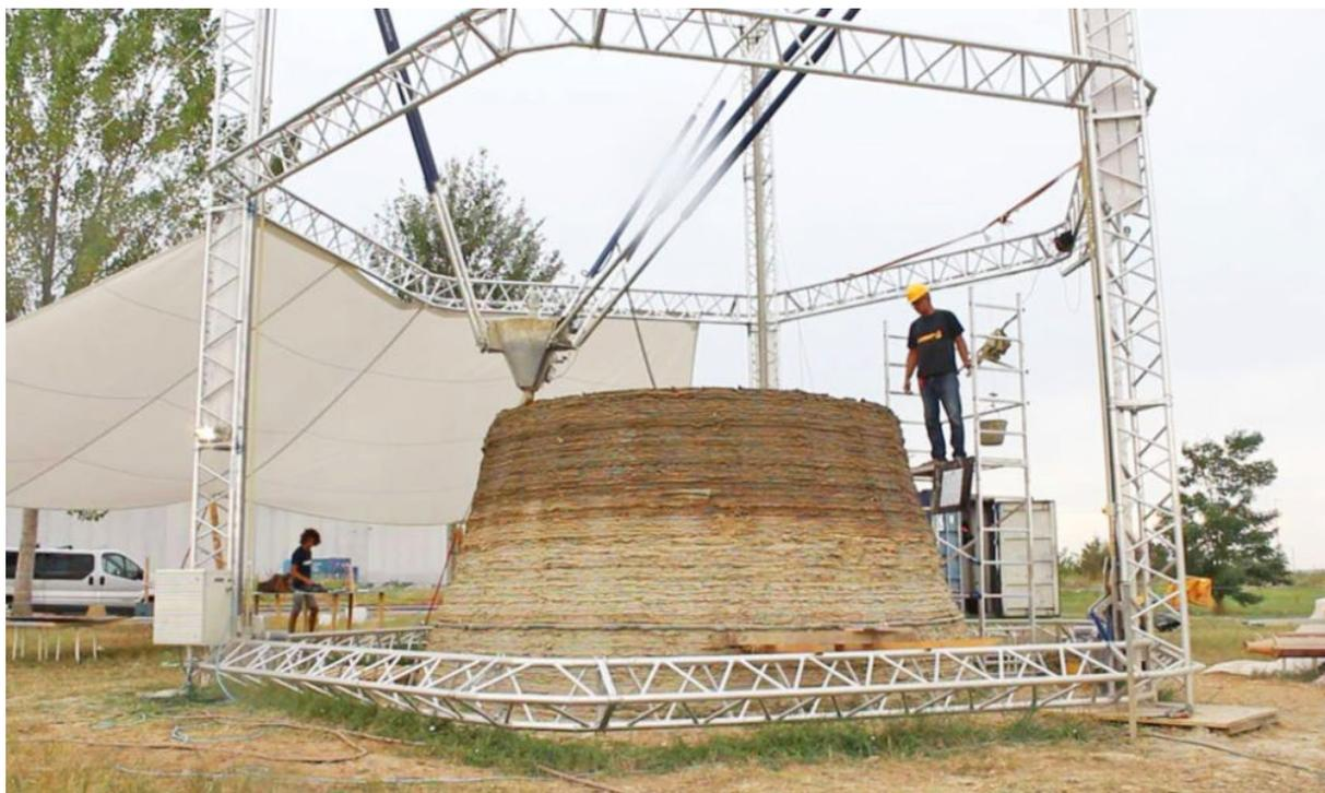
Рисунок 2. Конструкция 3D принтера типа «Дельта» фирмы WASP
