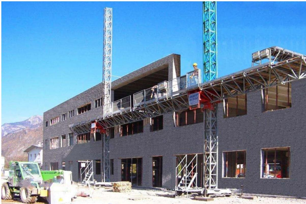
Рисунок 1. Строительный портал 3D принтера АМТ
