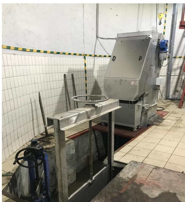
Рисунок 3. Реконструкция КНС ФИЦ СОО РАН (приемное отделение)
