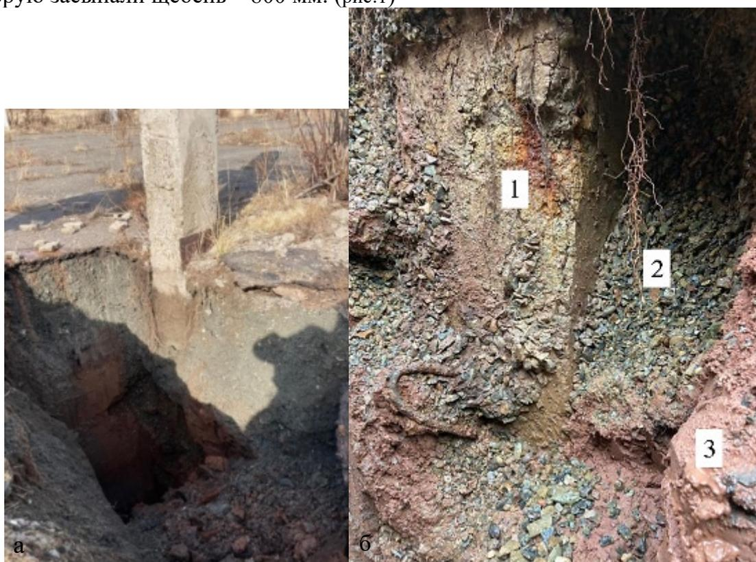
Рисунок 1. Отсутствие кольматации щебенистой противопучинной оболочки вокруг свай-колонны при отсутствии динамической нагрузки за 39 лет эксплуатации.
