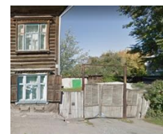
Рисунок 6 Деревянная ограда усадьбы доходного дома, г. Ачинск, ул. Пузановой, 36
