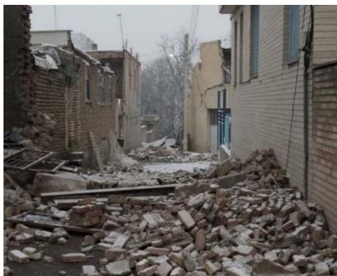
Рисунок 3. Последствия землетрясения в Иране 2023г.
