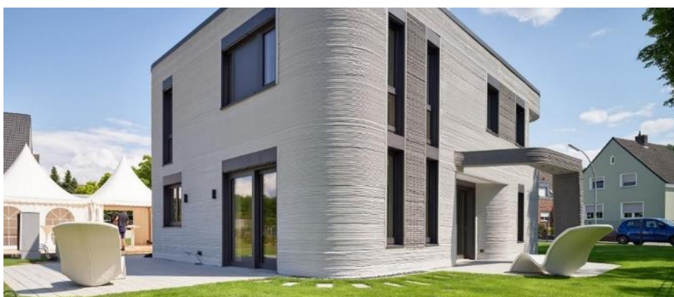
Рисунок 2. Слоистость, в связи с недостаточной жёсткостью конструкции принтера
