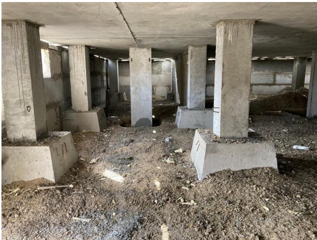
Рисунок 1. Подвал здания, построенного по системе «КУБ-2,5»
