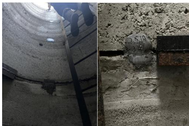
Рисунок 3. Система марок на швах колец
