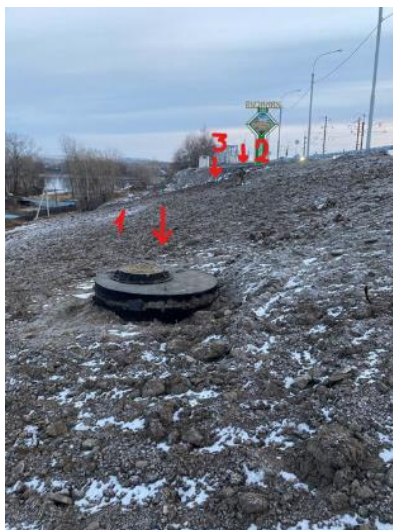
Рисунок 2. Дренажные колодцы 1,3. Наблюдательный - 2
