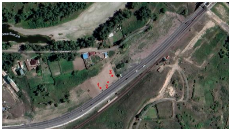
Рисунок 1. Приближение автомобильной и железных дорог к мосту через Енисей
