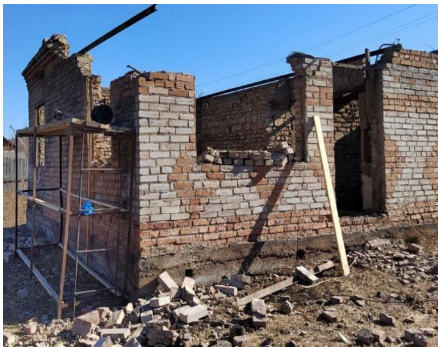
Рисунок 1. Одноэтажное кирпичное здание в г. Абакане
