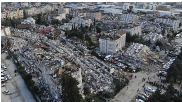
Рисунок 1. Последствия землетрясения в Турции 2023г.
