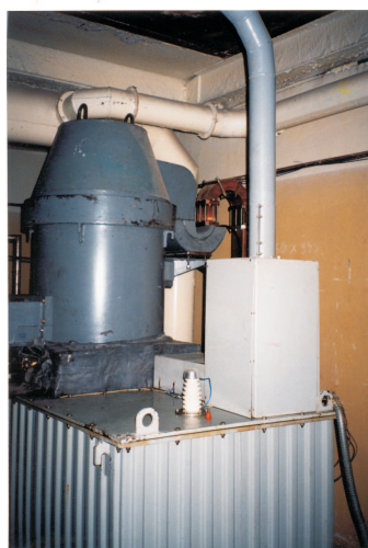
Рис. 9: Клистрон с импульсным в/в трансформатором и биозащитой.
