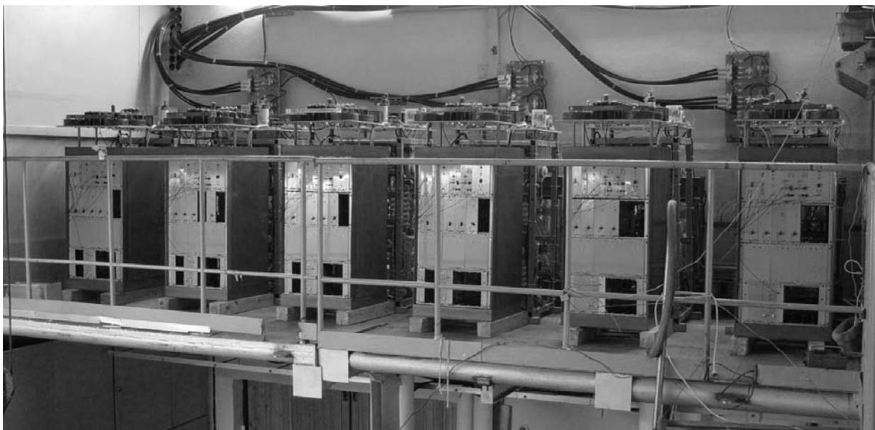
Рис. 7: Общий вид высоковольтной части новой системы питания установки ГДЛ. (показано 6 из 8-ми модулей)
