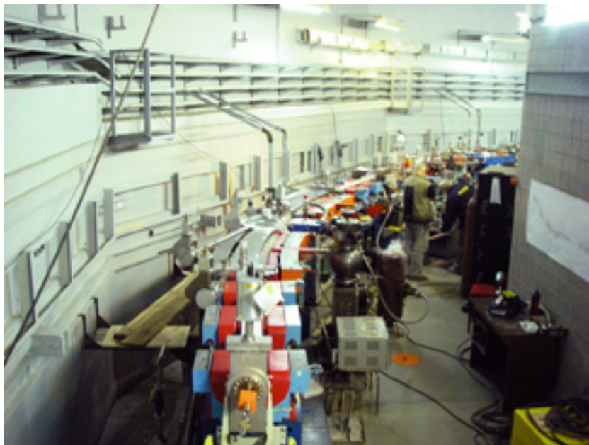
Рис. 39. Рабочий момент монтажа вакуумной системы большого кольца источника СИ “Зеленоград”.
