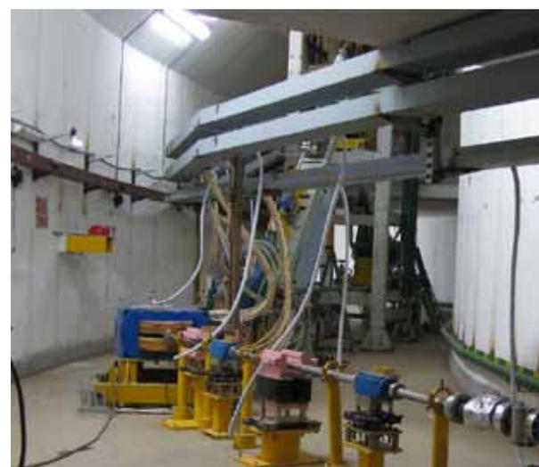
Рис. 5.3. 4. Спуск пучков в тоннели транспортных каналов Инжекционного комплекса.
