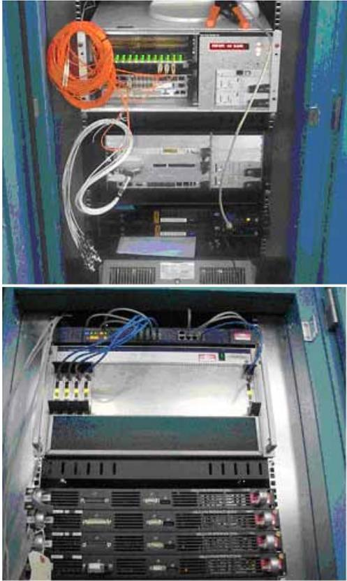
Рис.5.13.22 Аппаратура для управления источниками питания.
