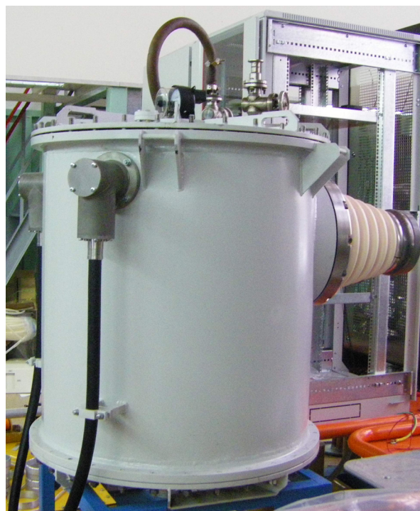
Рис. 7.9.1. Разделительный ВЧ трансформатор.
