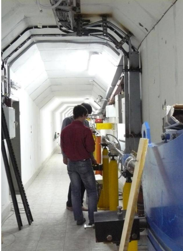
Рис.5.1.13. Тоннель канала К-500.
