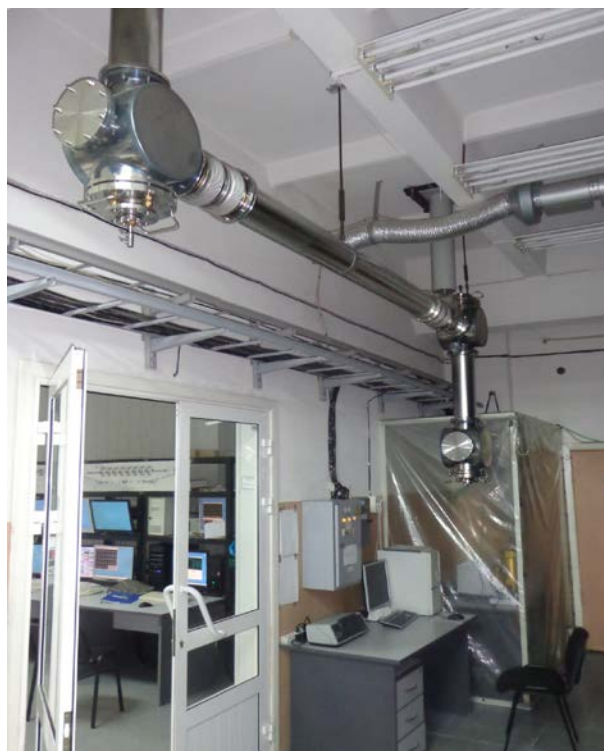
Рисунок 4 – Новый участок канала для вывода излучения (1 этаж).
