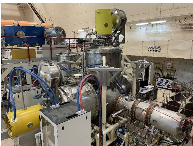
Рисунок 1. Установка КОТ в защищённом зале.
