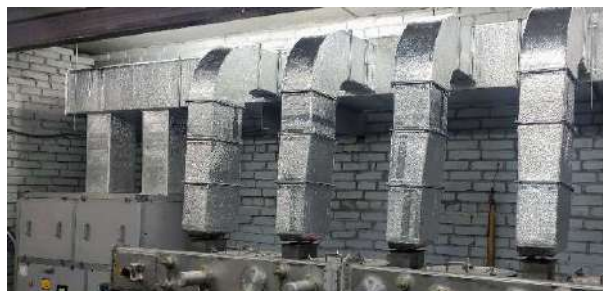
Рисунок 17. Воздуховод от кондиционера до ВЧ-ламп бго каскада.
