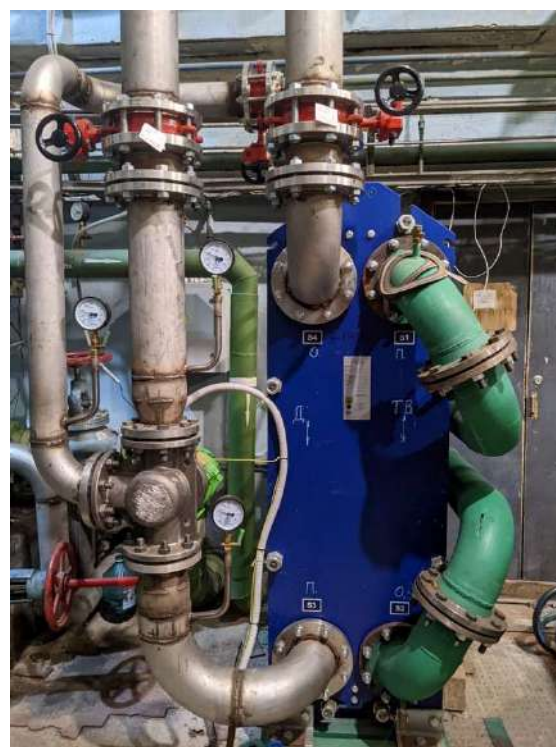
Рисунок 22. Пластинчатый теплообменник ТО-4 с обвязкой.
