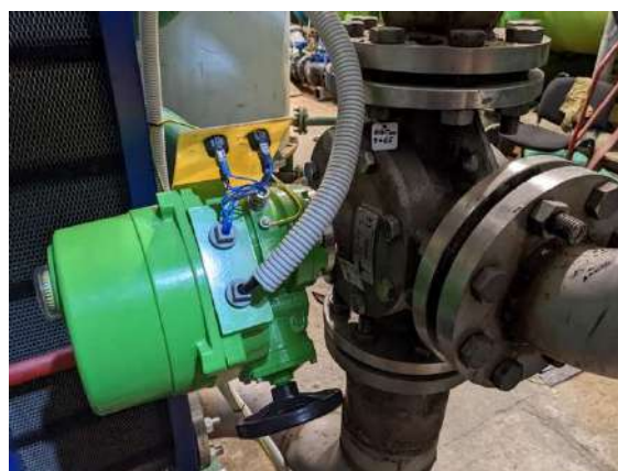
Рисунок 21. Установленный электропривод VB-300.
